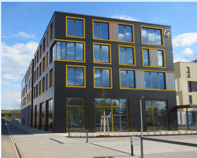
Das neue Kammergebäude in der Zimmerstraße
